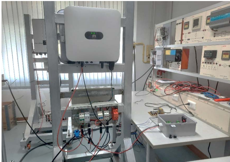
ภาพที่ 8 การทดสอบการวัดกำลังไฟฟ้าด้วยชุดวัดกำลังไฟฟ้าของระบบผลิตพลังงานไฟฟ้าด้วยเซลล์แสงอาทิตย์
