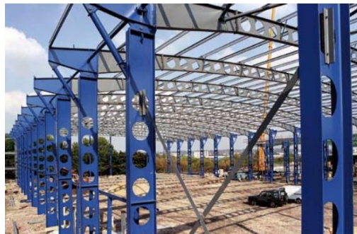
ภาพที่ 2 อาคารโรงงานระบบโครงสร้าง Cellular Beam
