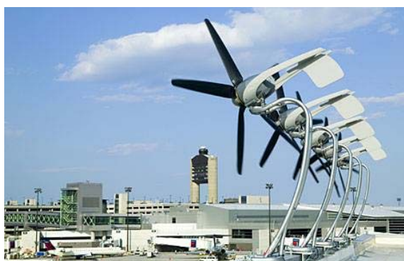
ภาพที่ 1 กังหันลมแกนแนวนอนที่ติดตั้งบนอาคาร
