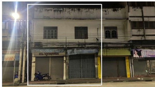
ภาพที่ 1 ลักษณะทางกายภาพด้านหน้าอาคารพาณิชย์ 2 คูหา 2 ชั้น ขนาดหน้ากว้าง 8 เมตร ลึก 18 เมตร สูง 8 เมตร
