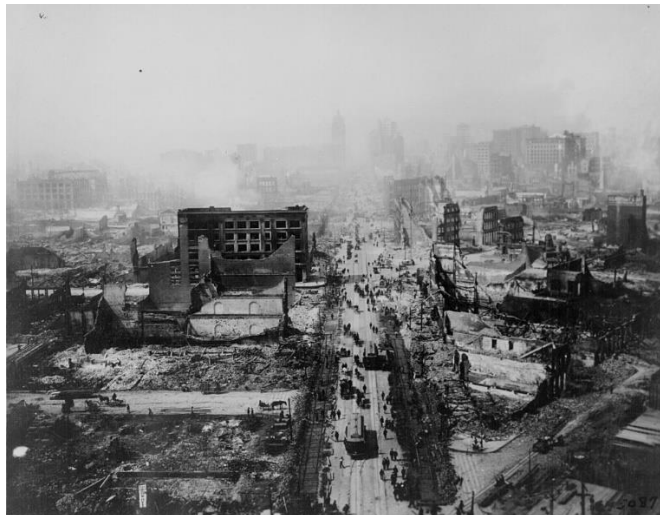
ภาพที่ 2 อาคารบ้านเรือนที่ได้รับความเสียหายจากแผ่นดินไหวที่สหรัฐอเมริกา ปี ค.ศ. 1906
