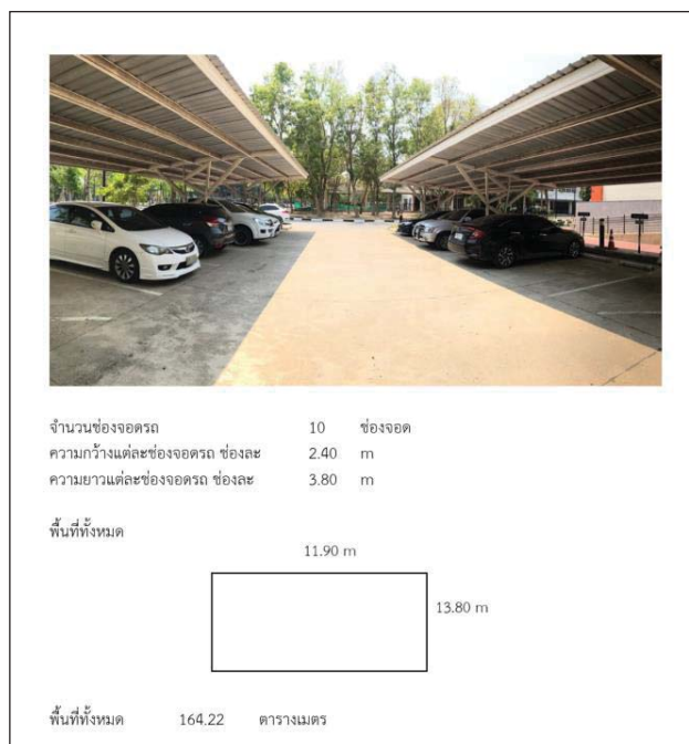
ภาพที่ 3 ตัวอย่างการบันทึกข้อมูลการสำรวจพื้นที่จุดจอดรถภาคพื้นดิน
