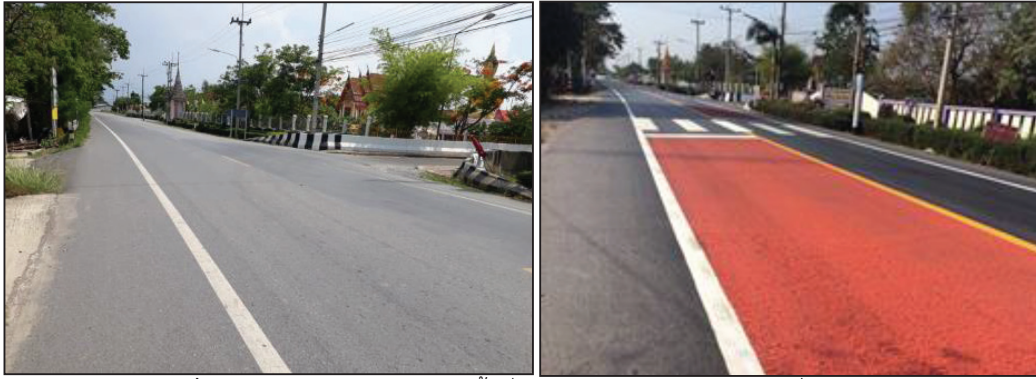
ภาพที่ 2 เปรียบเทียบตัวอย่างสภาพพื้นที่ก่อน และหลังการปรับปรุงจุดเสี่ยงทางถนน บริเวณสามแยกระหว่างโรงเรียน และวัดบางไผ่นารถ
